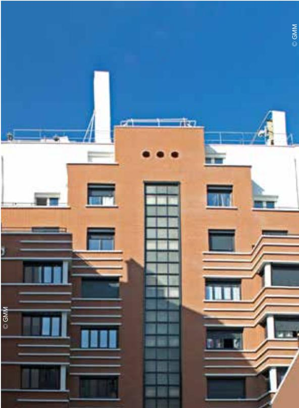
◀ PLAQUETTES ORGANIQUES ET BANDES FILANTES RÉALISÉES AVEC DES MODÉNATURES EN FIBRE DE VERRE RÉCRÉENT À L'IDENTIQUE L'ESTHÉTIQUE DE CE BÂTIMENT INDUSTRIEL PARISIEN APRÈS MISE EN ŒUVRE D'UNE ITE.
